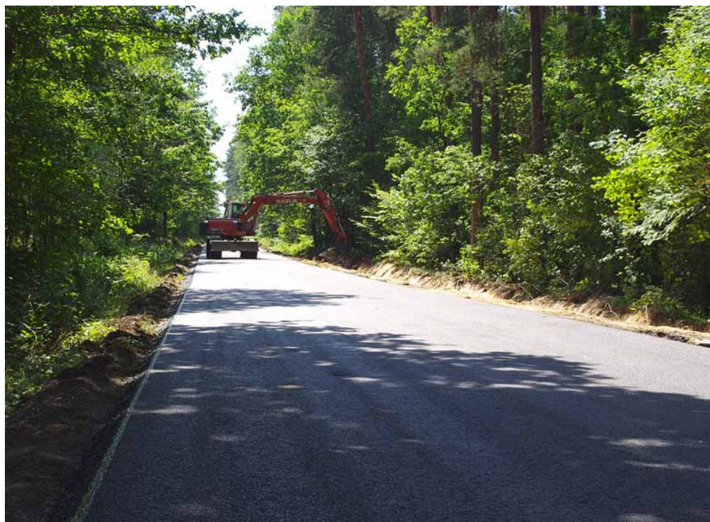
▲ Postęp prac na drodze powiatowej
