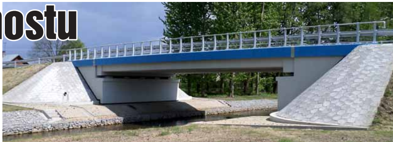
▲ Most po przebudowie.
