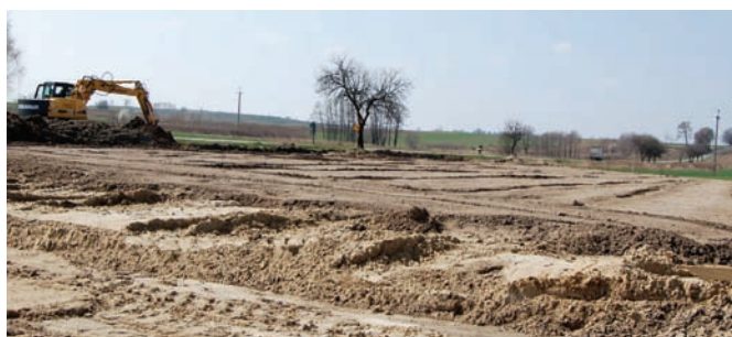
▲ Przygotowywanie terenu pod budowę boiska sportowego w Grodzisku Nowym.
