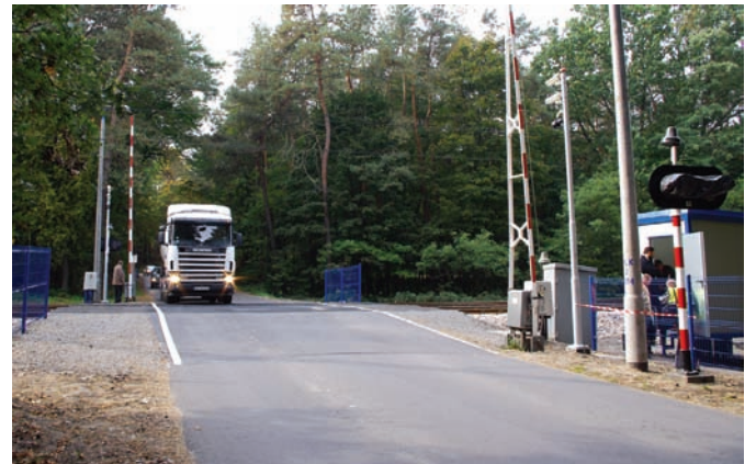
▲ Przejazd w ciągu linii kolejowej Nr 68 Lublin – Przeworsk
