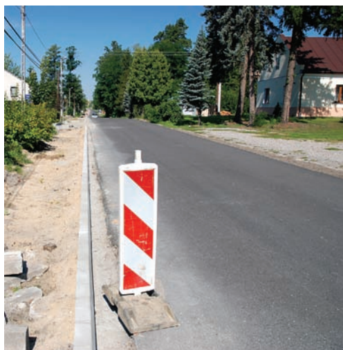
▲ Przebudowa drogi 1259R w Giedlarowej
