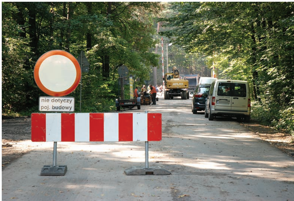
▲ Przebudowa przejazdu kolejowego na Przychojec
