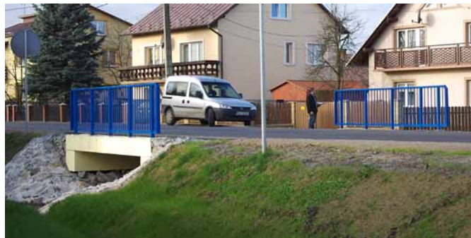
▲ Wyremontowany most w ciągu drogi powiatowej Hucisko na odcinku Hucisko – Ruda Łańcucka.
