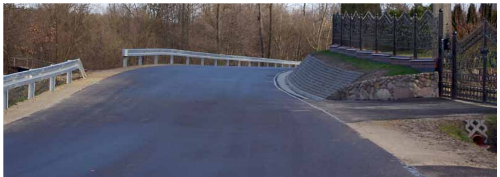
▲ Przebudowa drogi powiatowej na odcinku Hucisko – Ruda Łańcucka.
