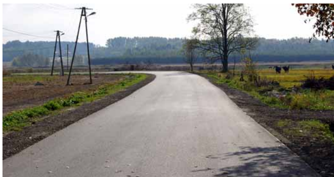
▲ Przebudowa drogi powiatowej Brzyska Wola – Kolonia Polska w miejscowości Brzyska Wola.
