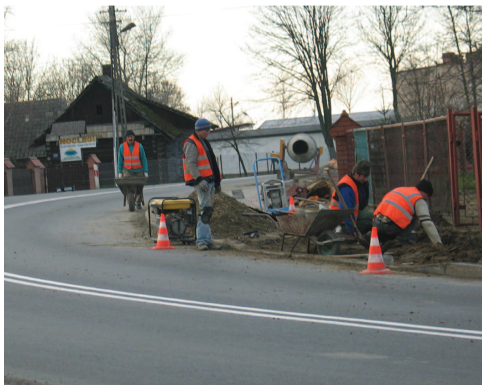
Prace przy chodniku w Dębnie
