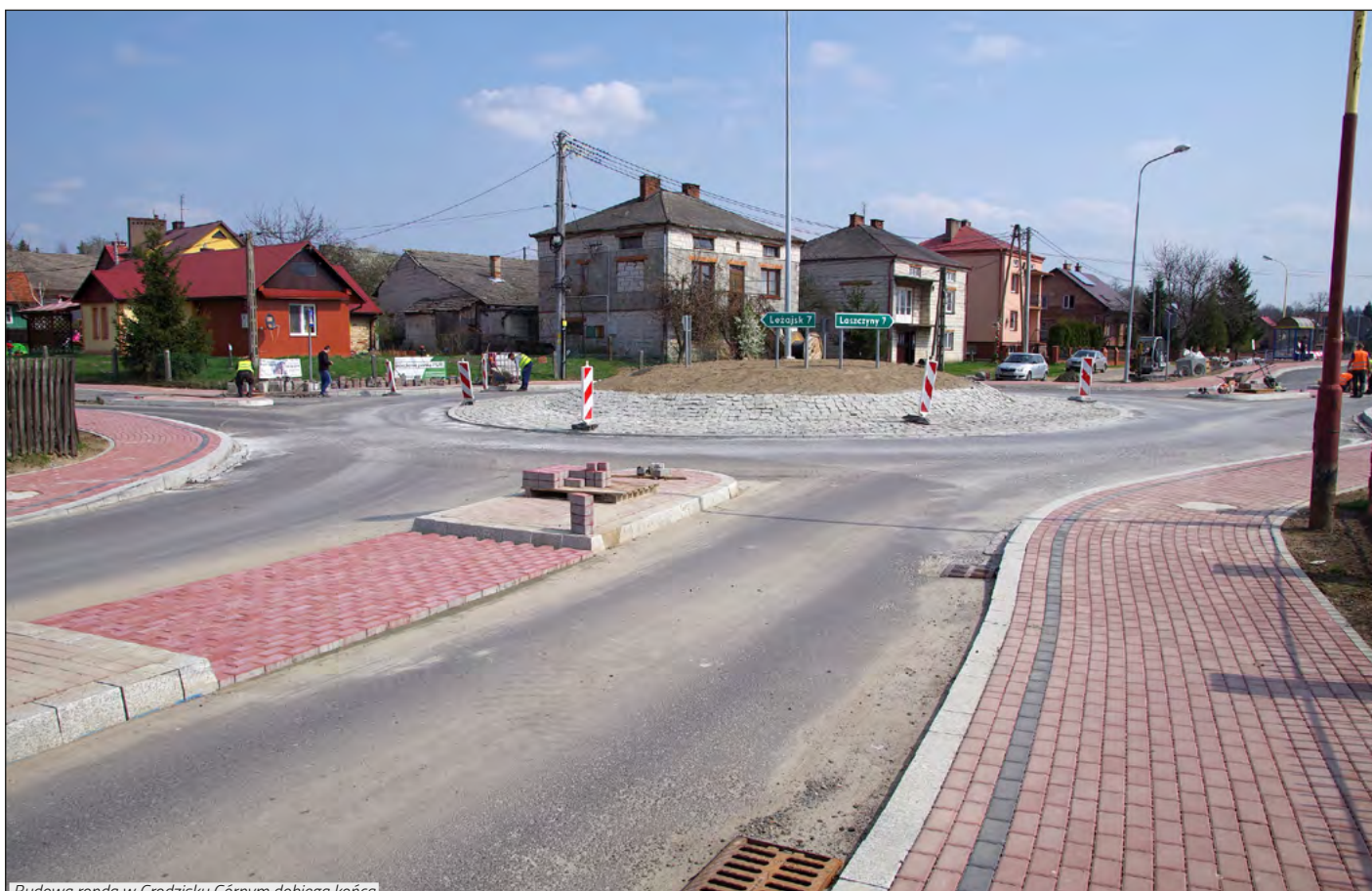
Budowa ronda w Grodzisku Górnym dobiega końca
